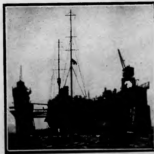
O GLASGOW, fazendo reparos no dique fluctuante Aff. n o Penna. (Rio de Janeiro) depois do combate travado em Coronel.
