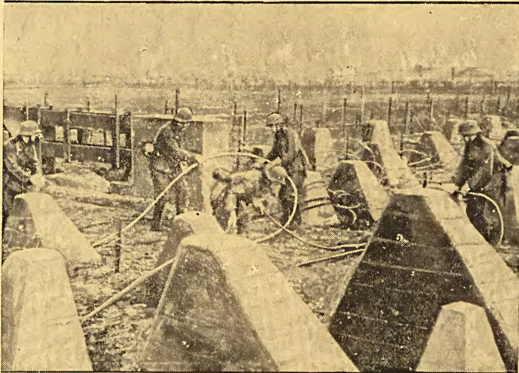
Von der Westfront — Eine Seilsperre wird geschlossen.
