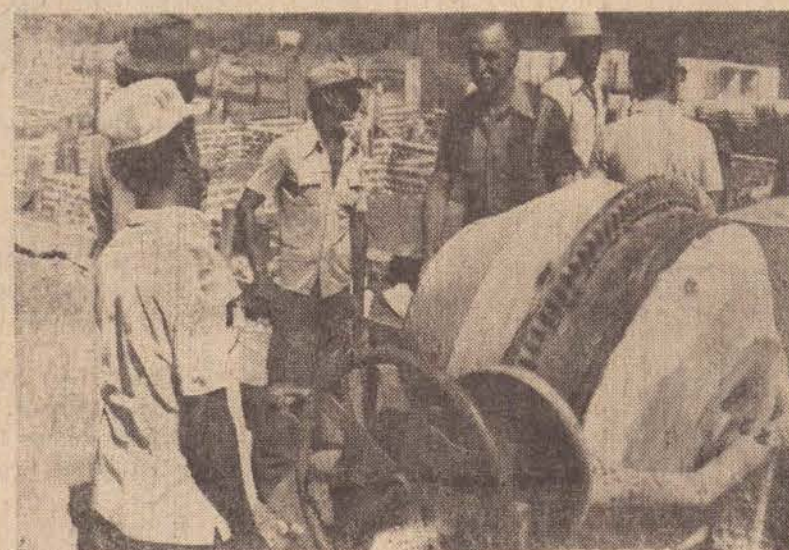
O prefeito visita o canteiro de obras do núcleo residencial do Inocoop.
