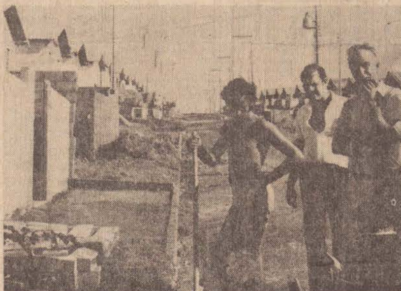
...e às ruas da Cohab onde a pavimentação será refeita.
