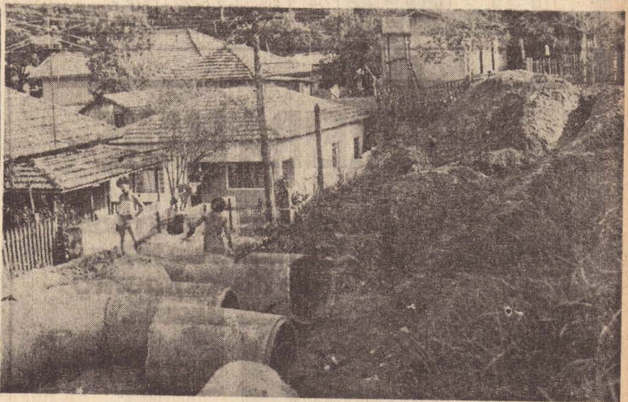
Tubos para galerias, na rua Teófilo Nascimento, em trecho a ser pavimentado.
