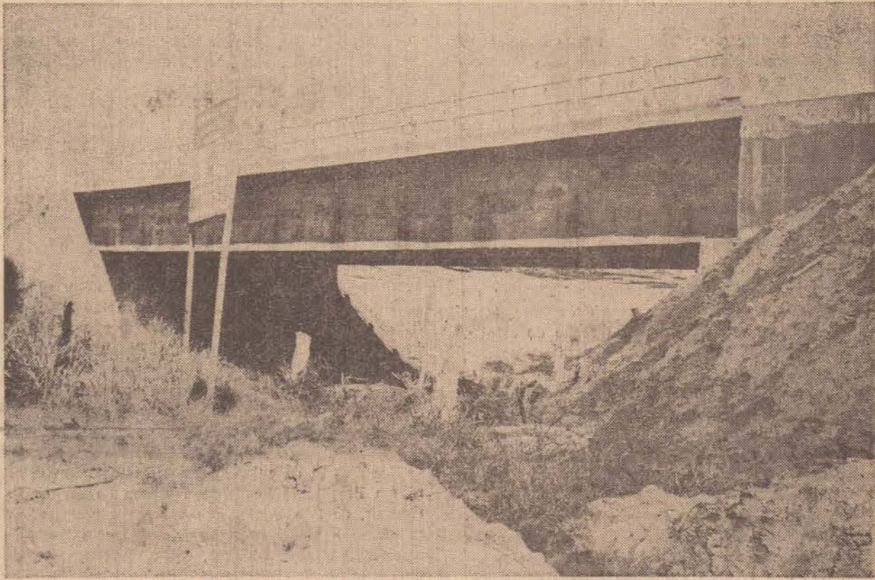
Ponte construída no distrito de Ameliópolis, custou 1,1 milhões.
