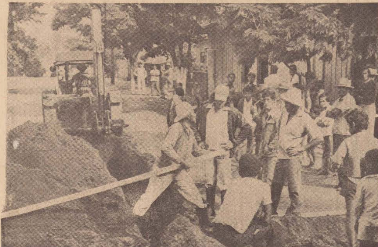
Construção da rede de distribuição de água em Floresta do Sul.
