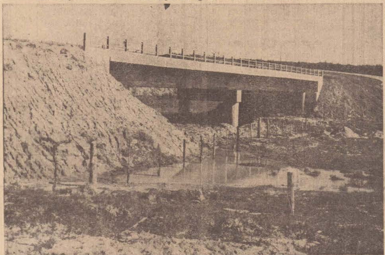
Ponte de cimento armado no bairro Mentolândia custou 1,2 milhões
