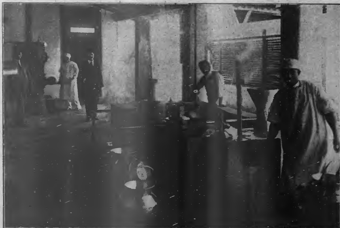
Salão de lavagem e esterilização do vasilhame, caldeira de pressão, e serpentina da machina de gelo.
