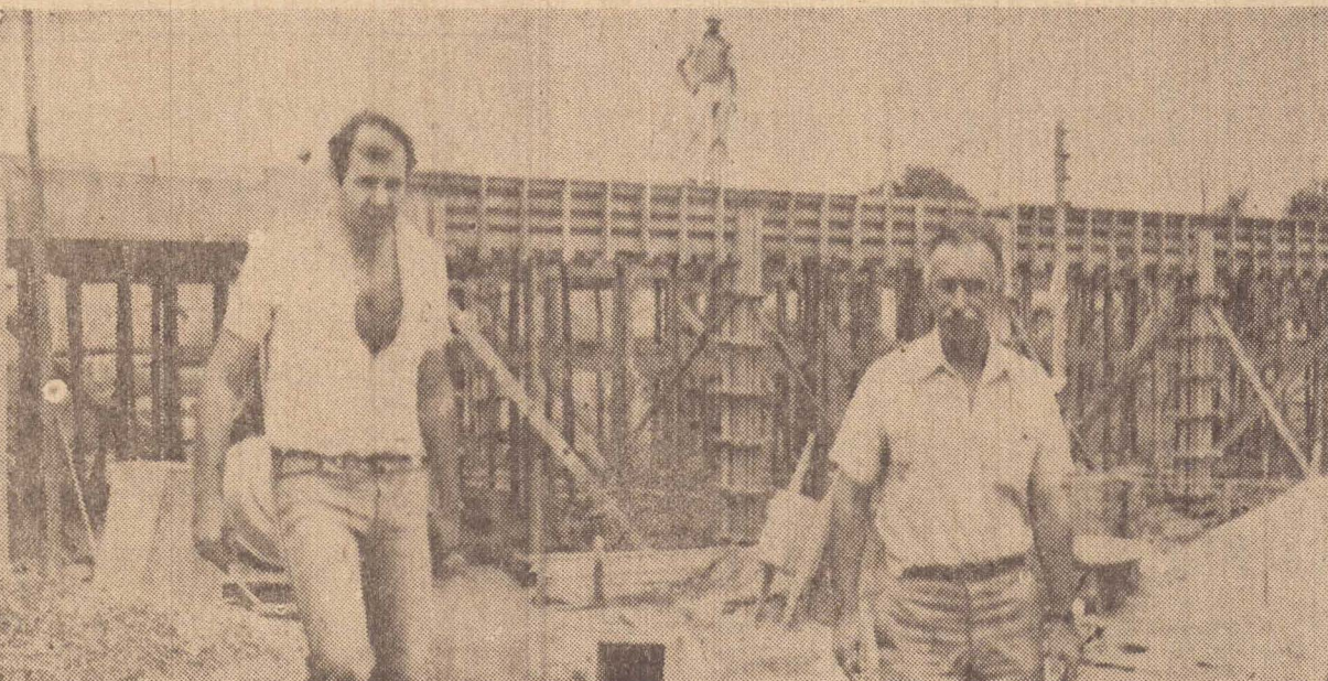
Aspecto do estagio de obras da Escola de Emergencia do Jardim São Gabriel inspecionadas pelo vice-prefeito.
