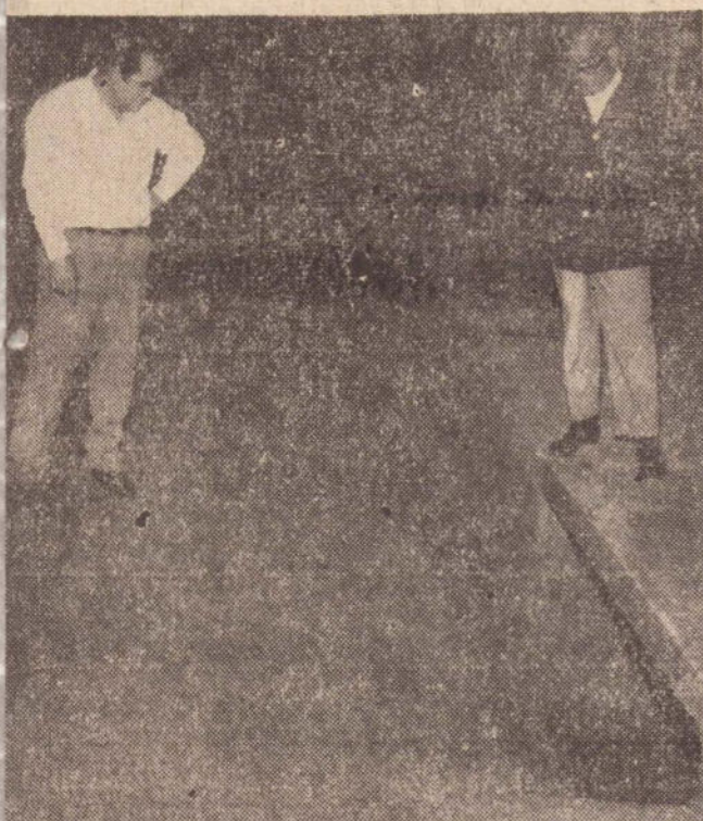
Esta boca de lobo sem qualquer grade de proteção e quase cinco metros de profundidade — uma ameaça constante aos moradores e principalmente às crianças que transitam pela Rua Julio Prestes,
