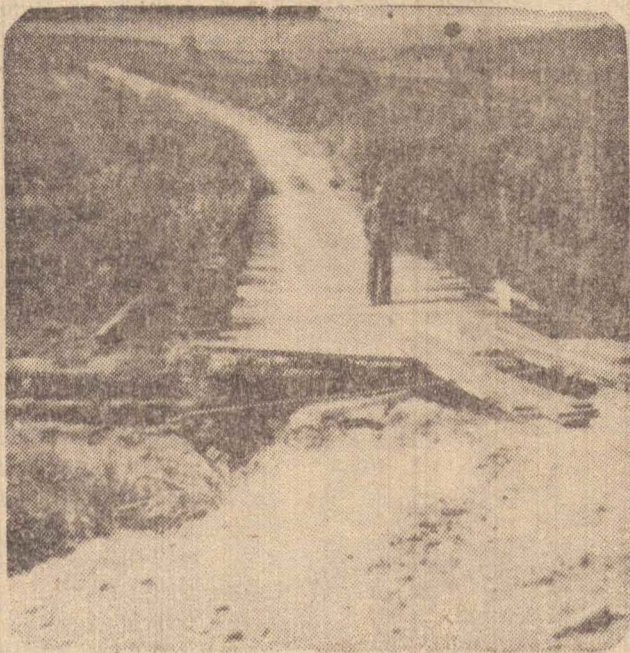
A Ponte do Cafesal - ANTES
