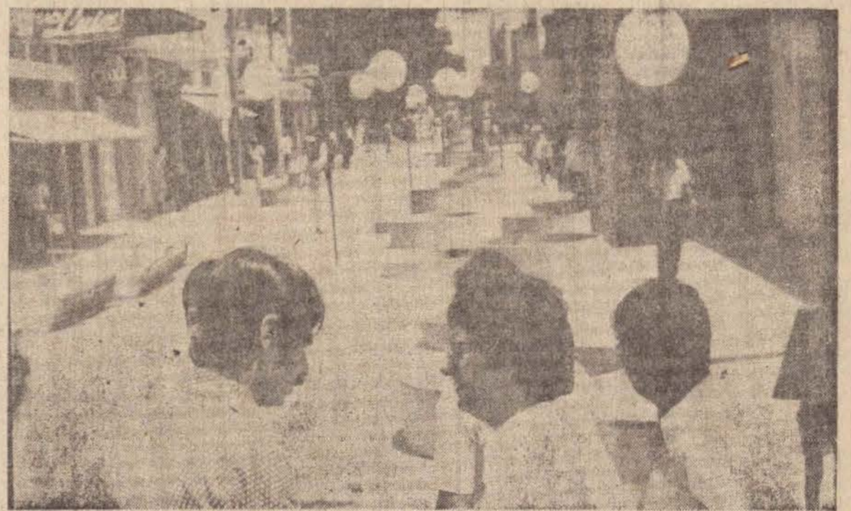
Esta semana o prefeito realizou várias inspeções às obras do Calçadão.
