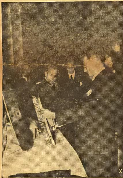
Der pannensichere Autoreifen. — Der Marine-Oberdeckoffizier a. D. Alfred Spencker (Stuttgart) hat einen selbsttragenden, überdrucklosen, elastischen und luftgekühlten Auto-Vollreifen erfunden. Durch eine eigenartige Anordnung von Kühlkanälen und einem Luft-Ansaugkopf, die unsere Abbildung deutlich erkennen lässt, wird hauptsächlich erreicht, dass die besonders bei hohen Geschwindigkeiten auftretende Reibungswärme weggesaugt und unwirksam gemacht wird.
