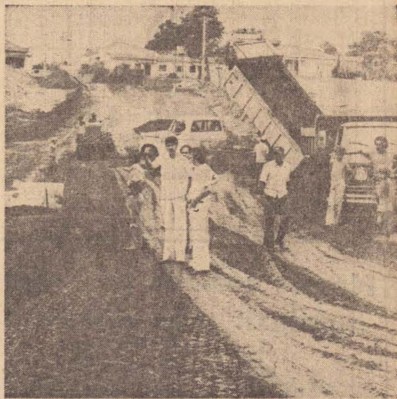
No vale do antigo correjo de águas poluída
