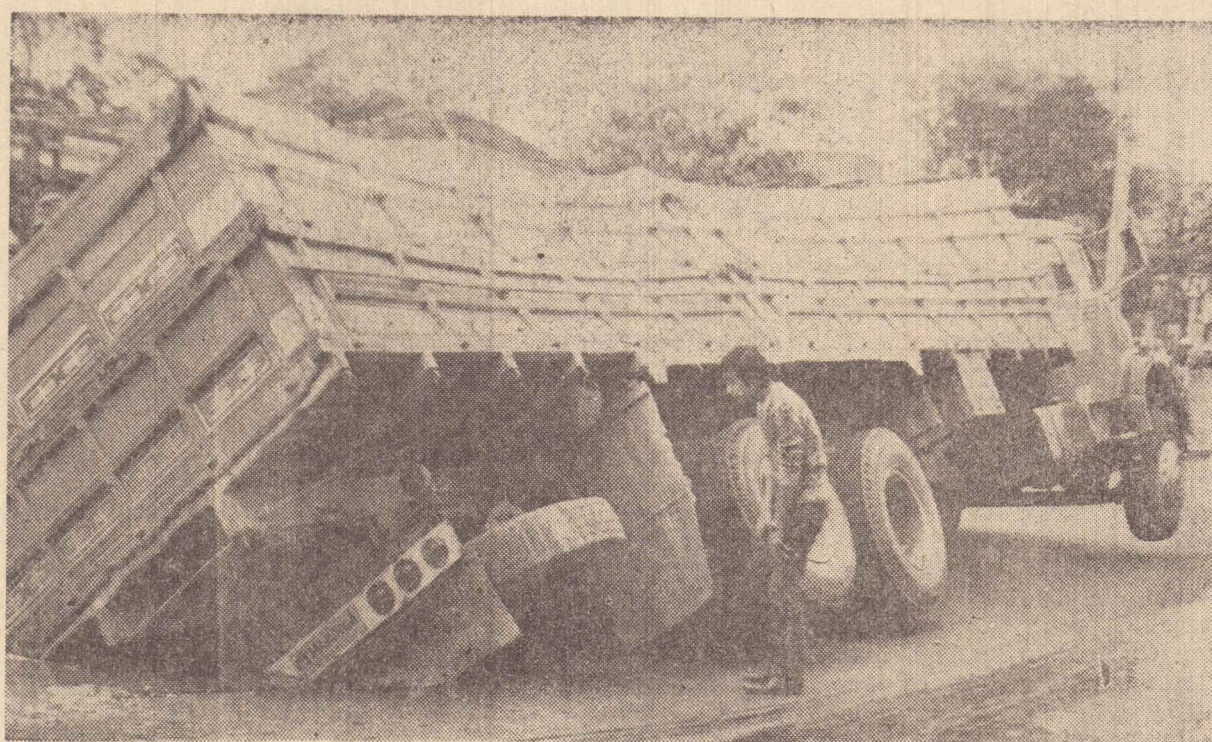
O asfalto, solapado, não suportou o peso do caminhão.
