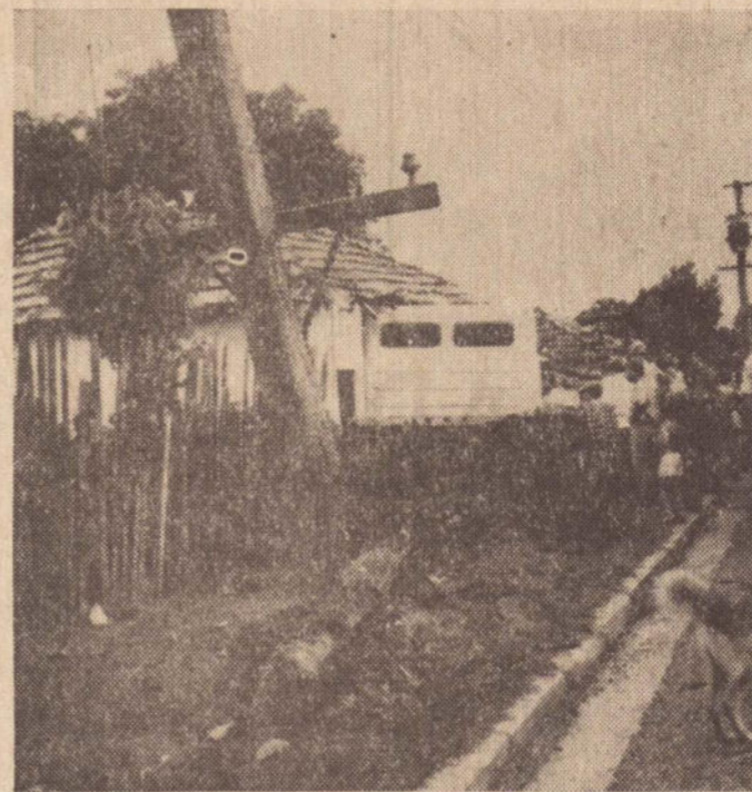
O FNM desgovernado destruiu o poste de madeira e entrou na casa, destruindo-a parcialmente.
