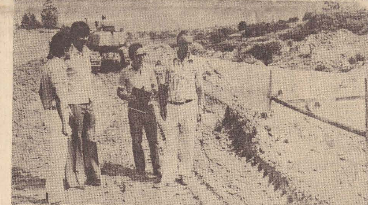
O prefeito, o vice-prefeito e o engenheiro da Prudente inspecionam as obras do Parque do Povo
