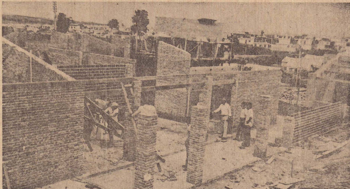
As obras estão em fase adiantada, com os prédios já levantados.
