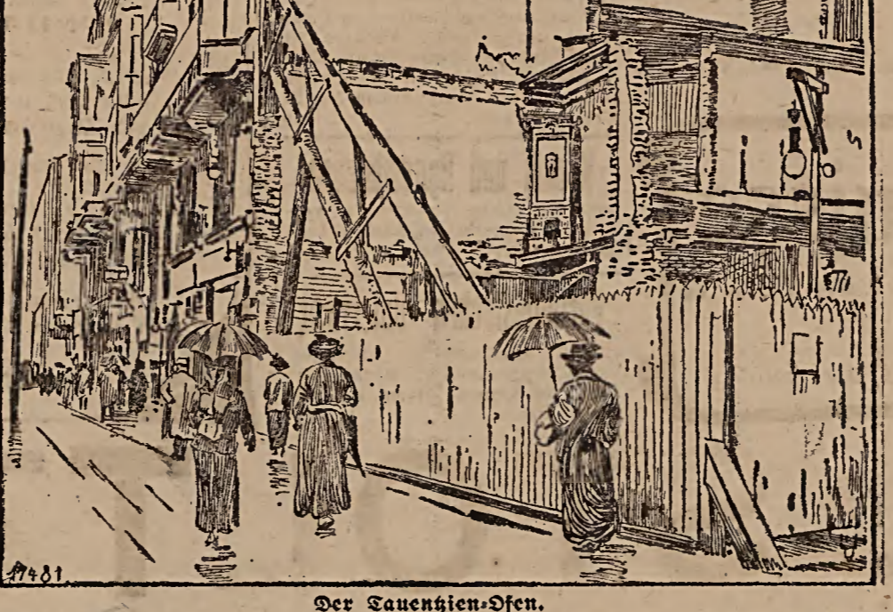
Der Taenagien-Ofen. Ziel Heiterkeit erregt zuerst in der Taenagienstraße, dem Bummelforlo von Berlin B., ein Ofen, der ehemals einem Gebäude Wärme spendete. Beim Abbruch des Hauses, das dem Untergrundbau weichen mußte, ist der Ofen freigeblieben und thront nun hoch über der Straße in einfacher Schönheit. Er soll der Architektur eines Kaffeehauses, das an der Ecke errichtet wird, als Wahrzeichen der „guten, alten Zeit“ einverleibt werden.
