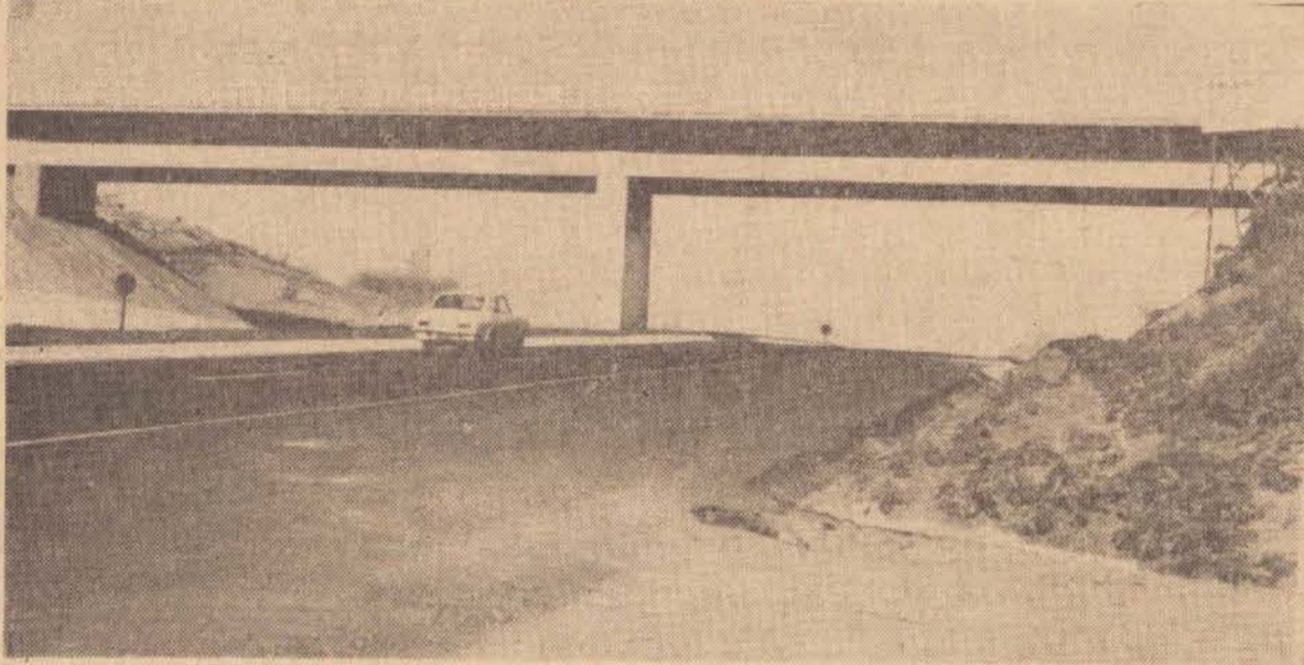
Este é o viaduto que a CALUX executou sobre a Raposo Tavares
