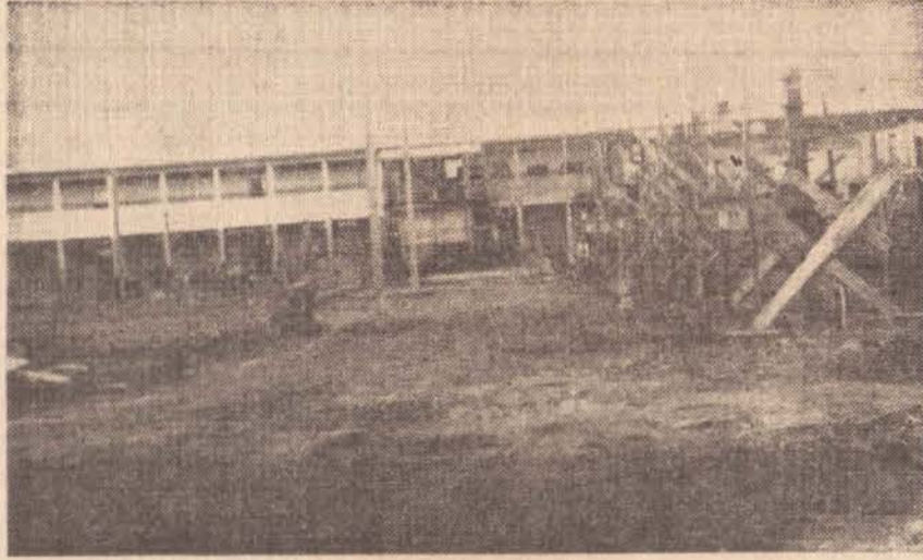
Estágio atual das obras do novo prédio escolar epitaciano
