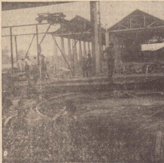
Trabalhadores providenciam a formação de lingotes do minério já fundido.
