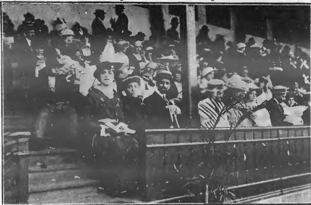
UM ASPECTO DA ARCHIBANCADAS
