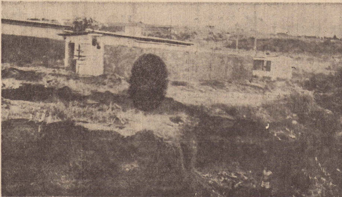
Na Cecap a erosão já ameaça uma residência.
