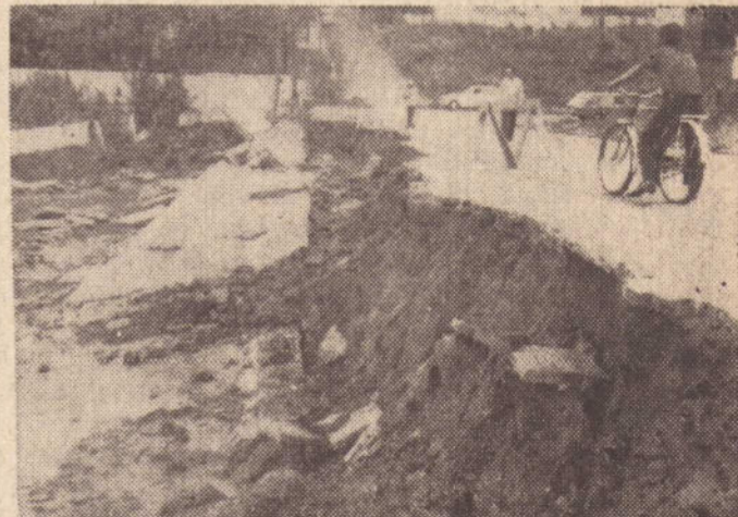
Muro e calçadas do Tennis Clube foram arrastados pela correnteza.
