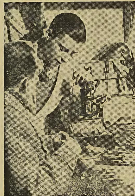
„Schönheit der Arbeit“ in deutschen Fabrikbetrieben. Unser Bild zeigt Lichtmessung am Arbeitsplatz eines Feinmechanikers mit dem Apparat zur Messung der Lichtstärke.
