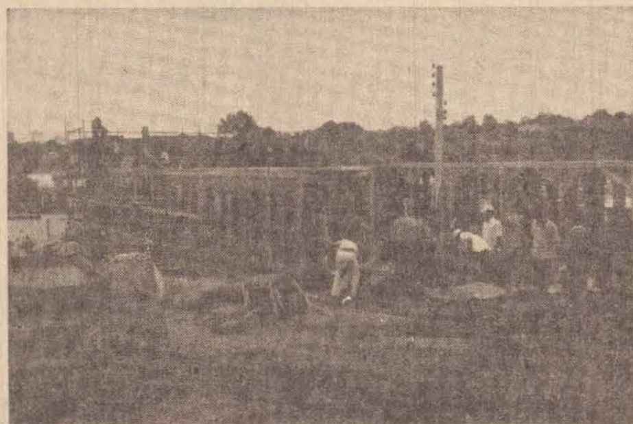
A sede da Congregação Cristã do Brasil em fase de construção.
