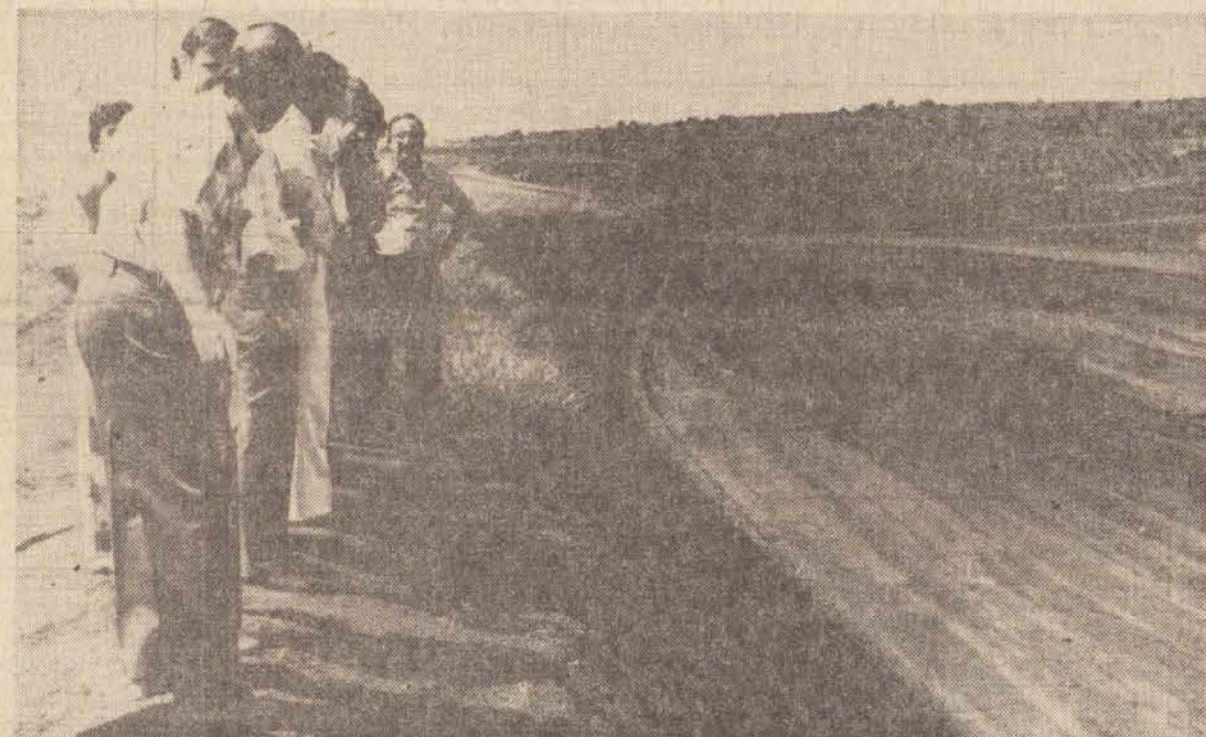
Todo o trecho do novo terminal ferroviário de Londrina está aberto, realizando-se atualmente as obras de arte, passagens subterrâneas etc. Até o final do ano será inaugurado o primeiro trecho da variante ferroviária.
