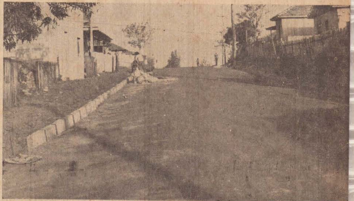
Aspecto de uma rua no Jardim Plavalto
