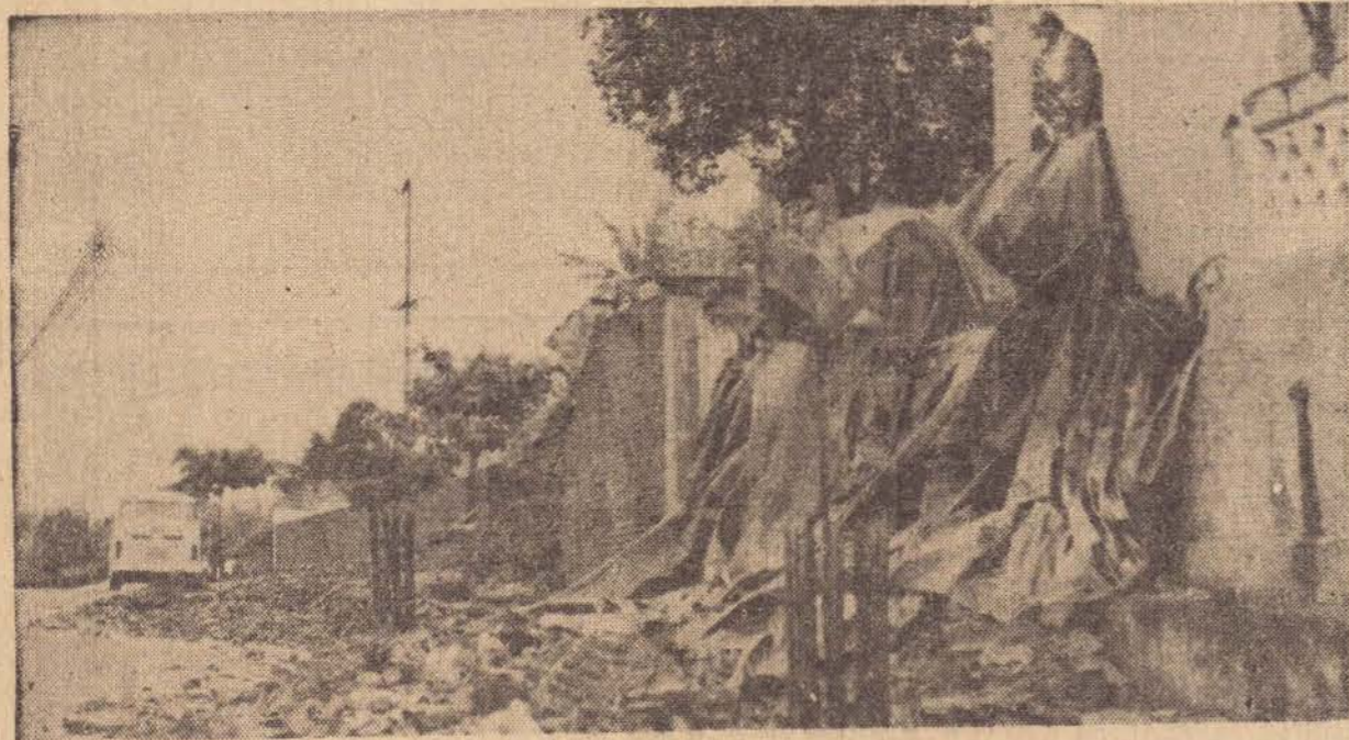
Desmoronamentos como este da rua Bahia, ocorreram em muitos pontos da periferia ontem, em virtude da intensidade das chuvvas.
