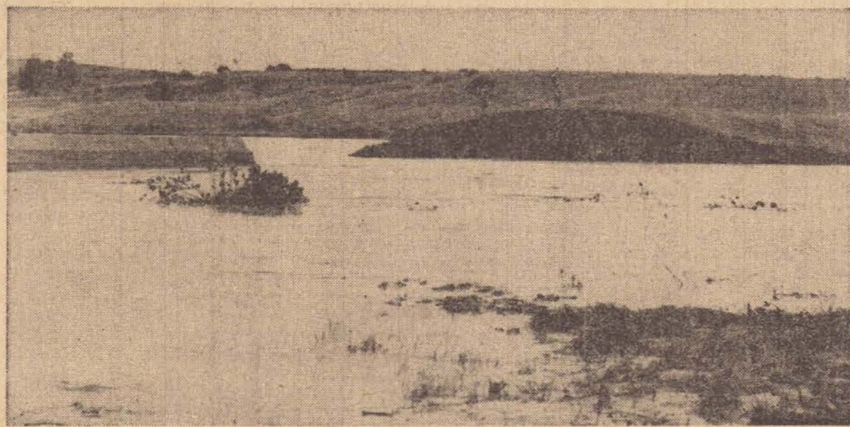
A barragem rompeu numa faixa de 15 a 20 metros.
