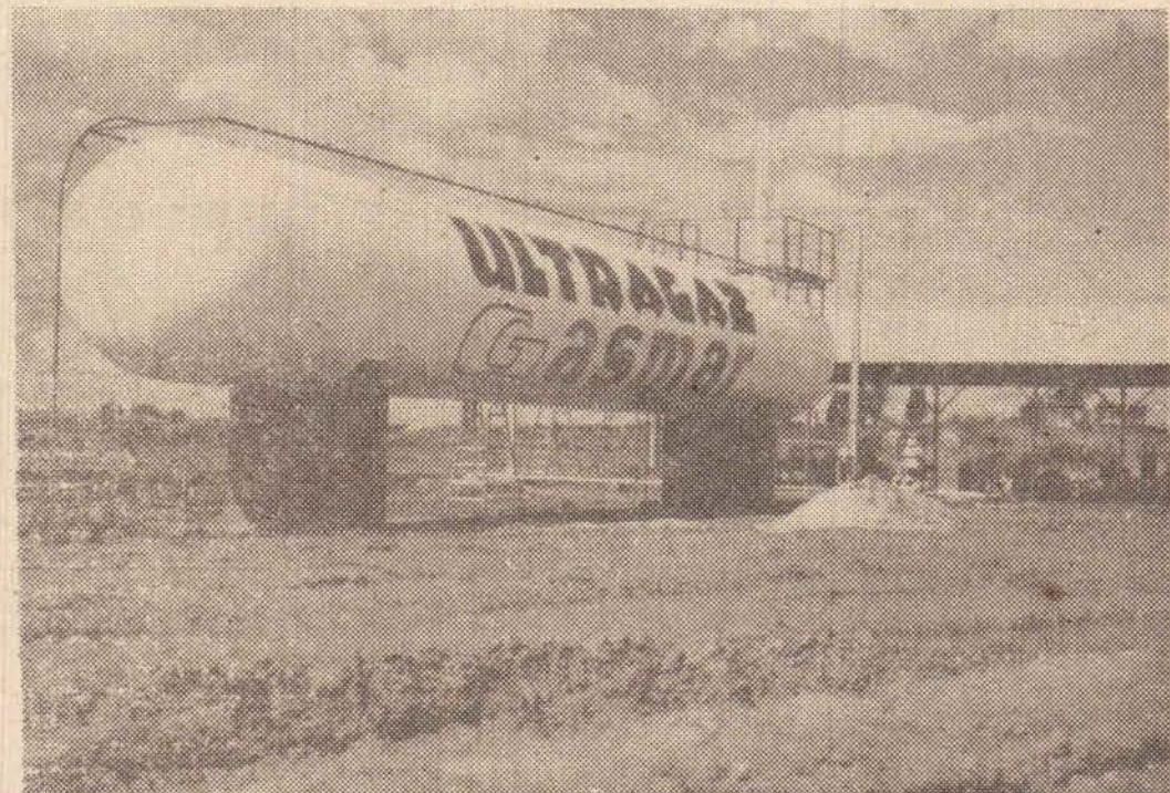
Na foto temos um dos três tanques reserva tóricos, que serão montados, sendo este o primeiro em fase de inauguração. Tem capacidade para 60 toneladas aproximadas ou sejam, 117,074 litros. Seu comprimento é de 20,060 metros.
