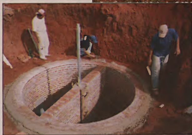
Abaixo, o biodigestor em obras e, ao lado, já pronto: assentados dominam técnica de construção
