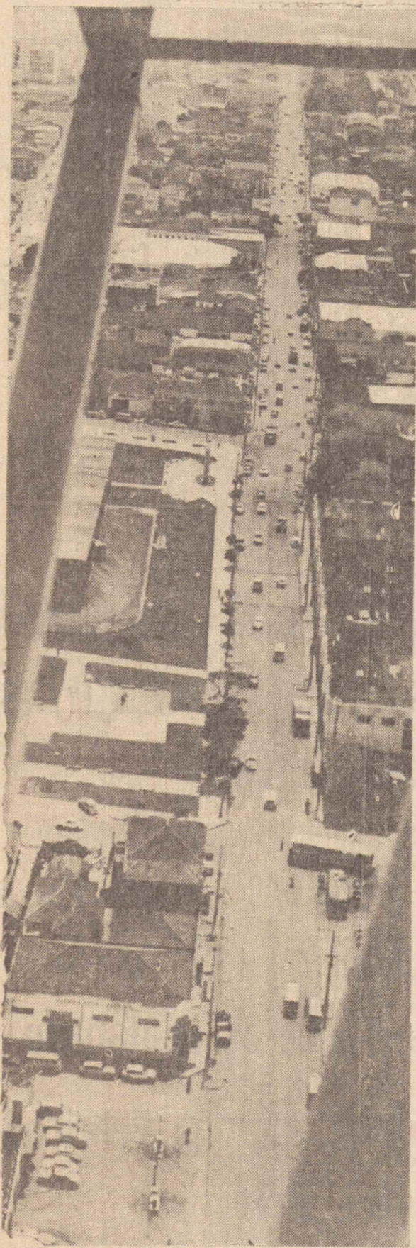
A Encalso é a responsável pela transformação que a cidade sofreu no início da administração Paulo Constantino. Um exemplo é o excelente serviço de recapeamento realizado na avenida Brasil, conforme a foto acima.
