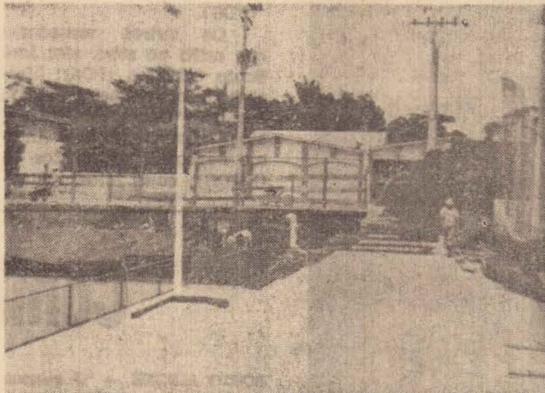
O muro de fundo, em recuperação.
