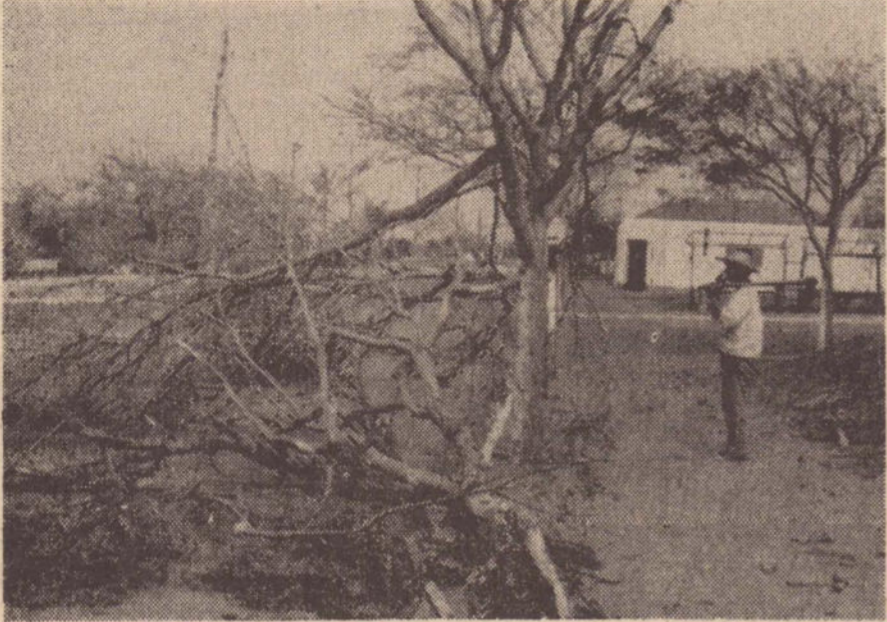
Durante todo o dia de ontem diversos operários cuidaram da desobstrução das ruas.
