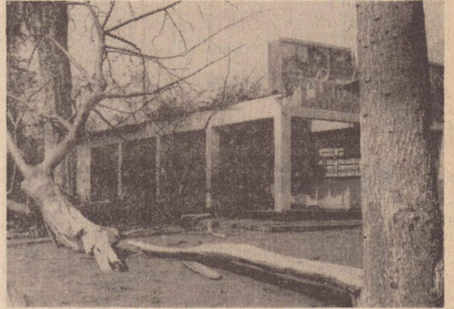
Árvores arrancadas e estabelecimentos destruídos, completam a tragédia de Panorama
