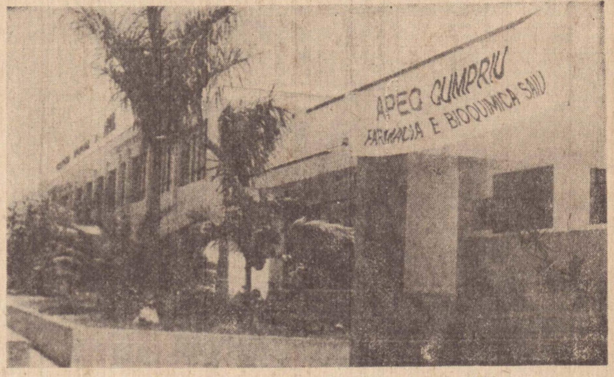
Vista parcial do grande complexo educacional da APEC
