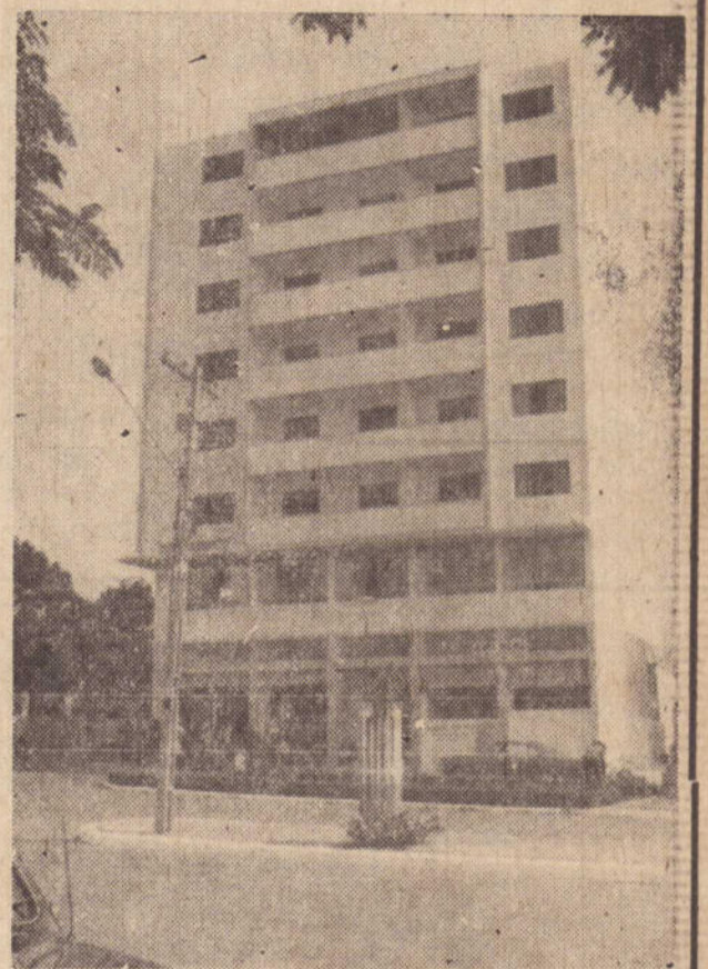
Pioneiro é o maior Edifício da cidade, situa-se na Praça Venceslau Braz.
