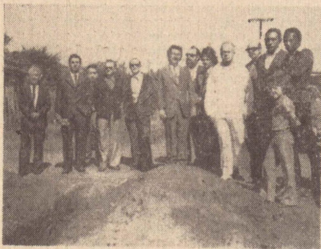
Na Vila Elohá, as autoridades verificam o início das obras da rede de água.
