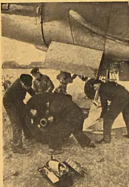
Este avião de combate alemão teve uma de suas rodas atingidas pelos tiros do inimigo, por ocasião de um raide contra este. Vemos aqui como o pessoal terrestre da Arma Aérea alemã retira, com perícia, a roda danificada do trem de aterrissagem.
