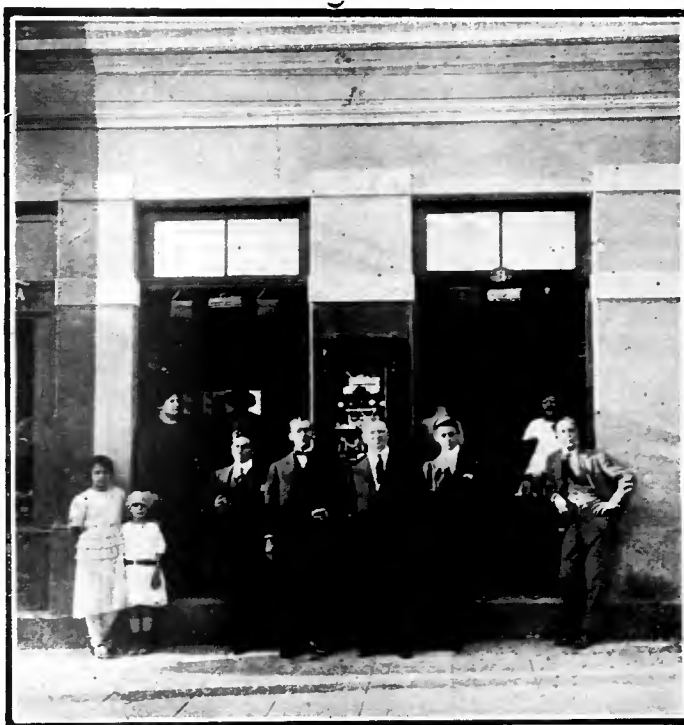
A frente do prédio onde funciona este estabelecimento, á rua Riachuelo n. 8. É de propriedade da firma Annuciata Saraceni & Comp. — Especialidade em machinas de costura, linhas e retroz para costureiras, bordadeiras, alfaiates e sapateiros, manequins, peças de machinas, agulhas de qualquer qualidade, oleo e correias, faz qualquer concerto, compra e vende machinas usadas. — Telephone 3931 Central.
