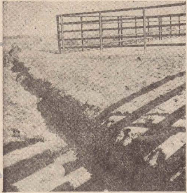
Para consolidar a implantação do embarcadouro no km 21, é necessário a realização de obras complementares para evitar a erosão que já está ameaçando a obra antes mesmo dela ter sido utilizada.
