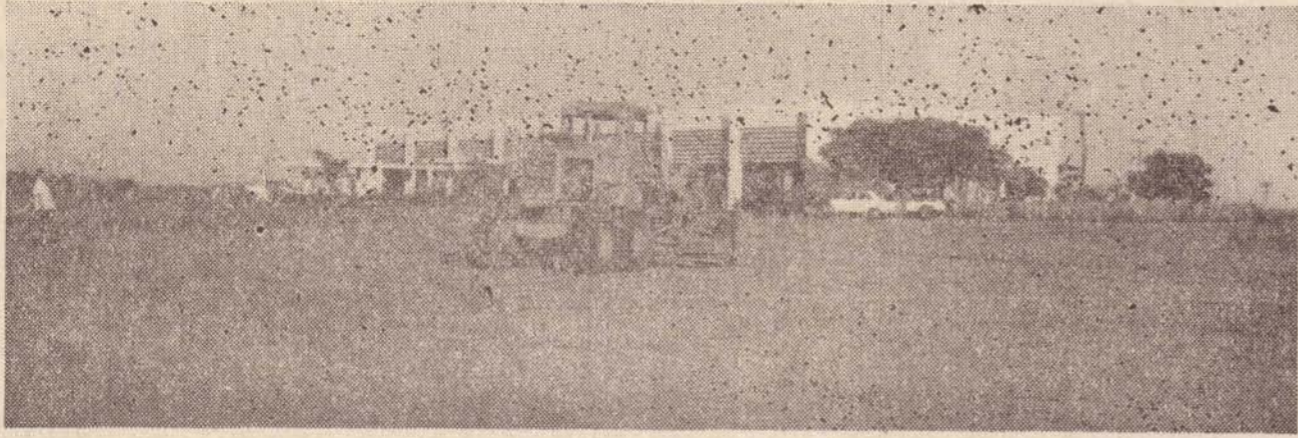
O pátio da Estação Aeroviária foi totalmente recuperado na última semana, por máquinas da Prefeitura Municipal
