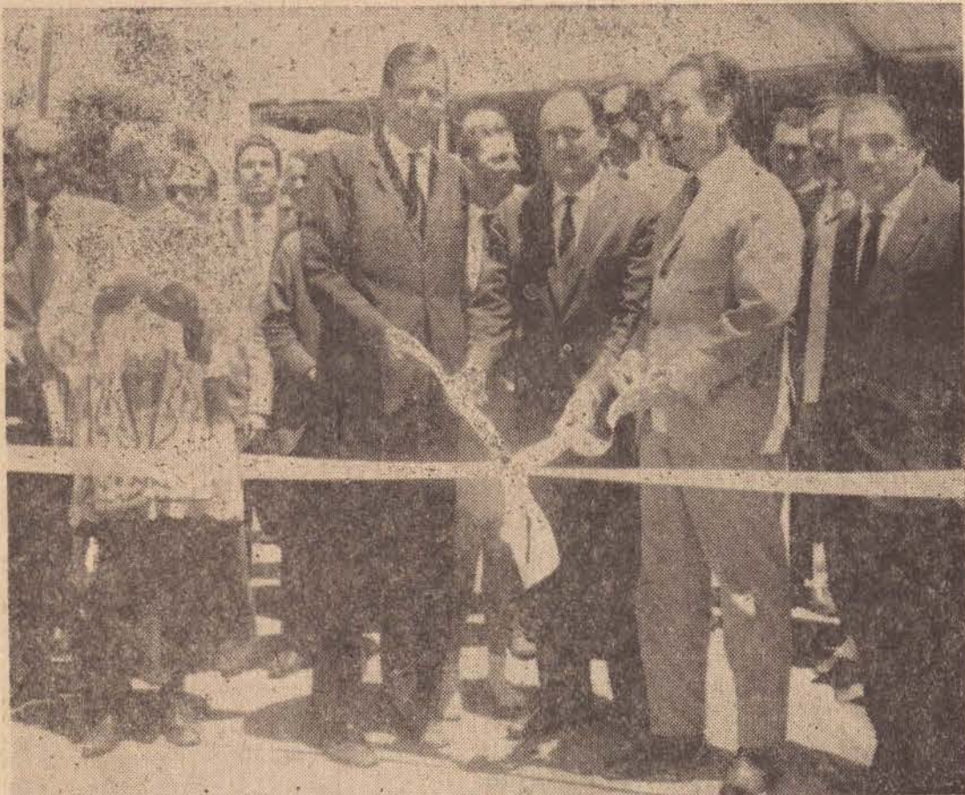
O prefeito Luiz Locatti, ladeado pelos srs. Onadyr Marcondes e Oscar Klabin Segall, desatam a fita simbólica dando por inaugurado o serviço de asfaltamento, guias e sarjetas da av. das Américas em Alfredo Marcondes
