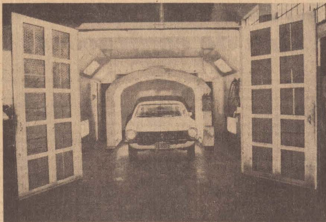
É a mais original e avançada técnica de pintura do seu Ford através da cabine estufa de pintura. Nela seu carro pode ser pintado até em dias de completa umidade.
