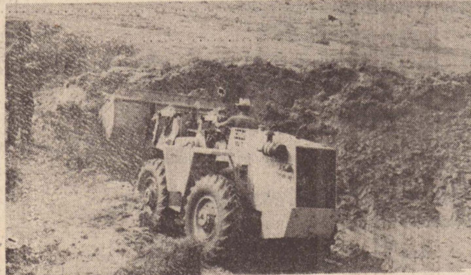
A retro-escavadeira Case da Prefeitura faz um açugue no município de Pirapozinho
