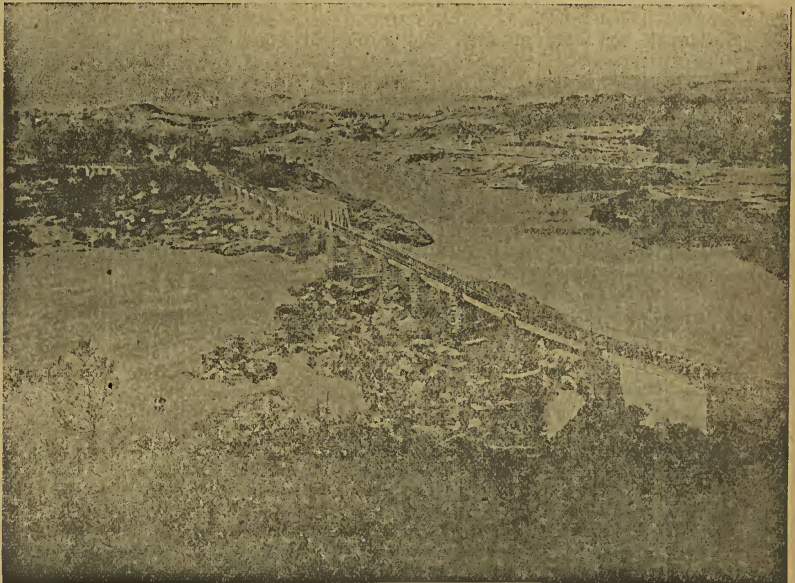
Aus dem Staate São Paulo. — Mogyana-Bahn. — Brücke über den Fluss Rio Grande.
