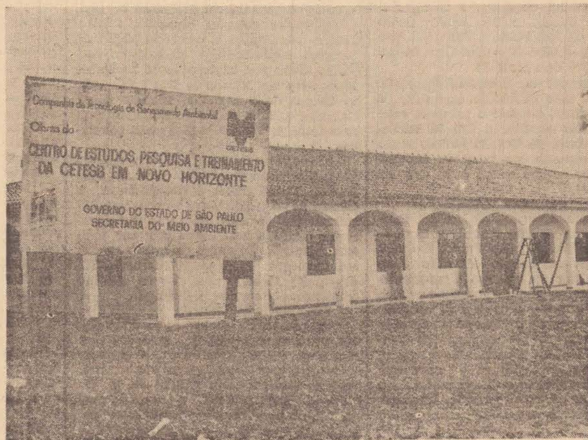
As obras do Centro de Pesquisa da Cetesb, em Novo Horizonte, estão em fase de acabamento.
