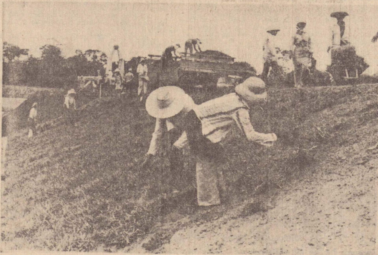
Mais de 100 pessoas, entre homens e mulheres, trabalham na colocação de grama na barragem.
