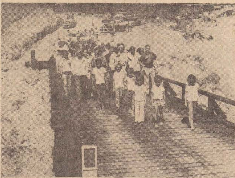
Autoridades e moradores do bairro Ponte Alta inaugurando a nova ponte construída sobre o Corrego da Onça.
