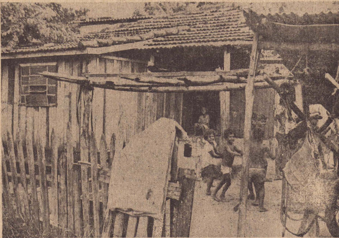
A casa do carroceiro José Dias Rocha, pai de Edna, no Jardim Monte Alto
