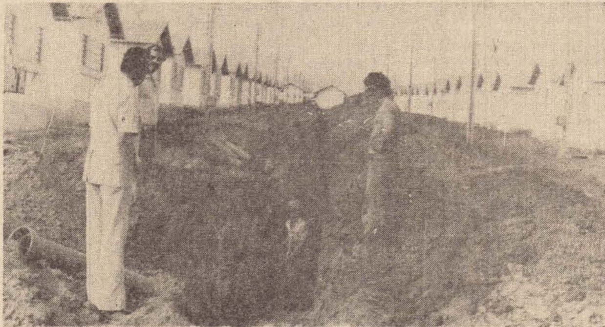
A Sabesp já está realizando suas redes de água e esgoto no novo bairro
