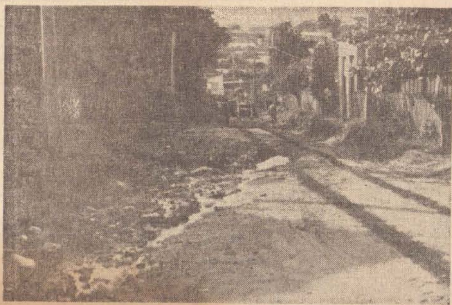
Antes do asfalto chegar, a rua Tomaz Rotta, no Jardim California era assim. Aguas pardas, enormes valetas, dificultando a vida de seus moradores.
